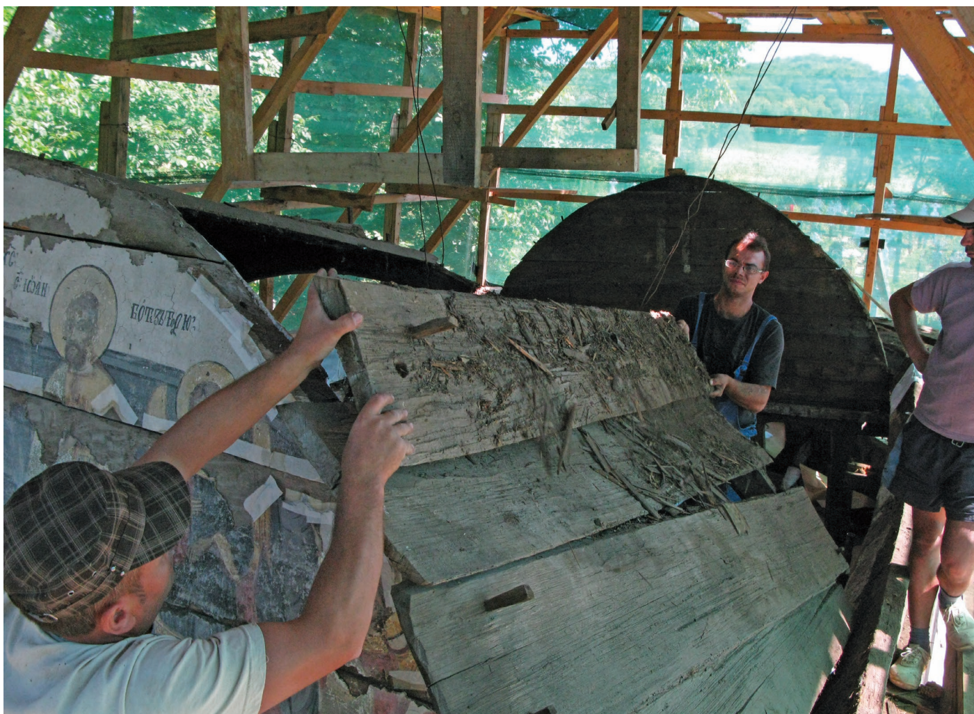
Fig. 12 Operațiunea de desfacere a scândurilor bolții (autor Dan Mohanu, 2012)
