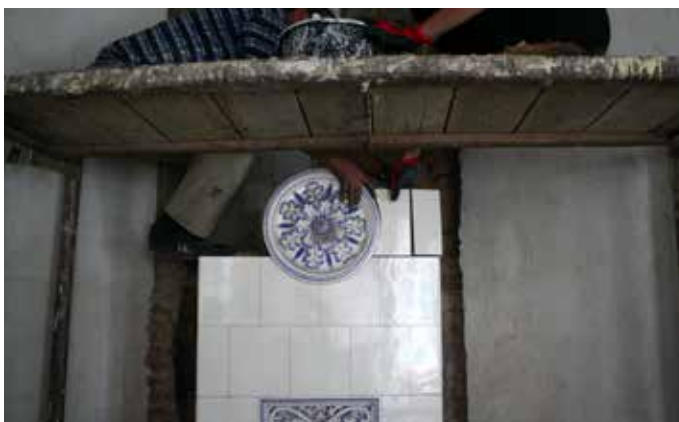
Fig. 19 Atelierul de construcție sobe, Țibănești 2015 (Alexandra Mihailciuc)
