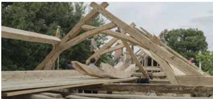
Fig. 11 Montarea fermelor atelierului „Batem fierul la conac!”, Țibănești, 2017 (Mihai Bodea)
