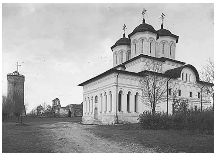
Fig. 27 Biserica Domnească „Adormirea Maicii Domnului”, Târgoviște, înaintea de restaurare, 1939 (N. Tațu)
