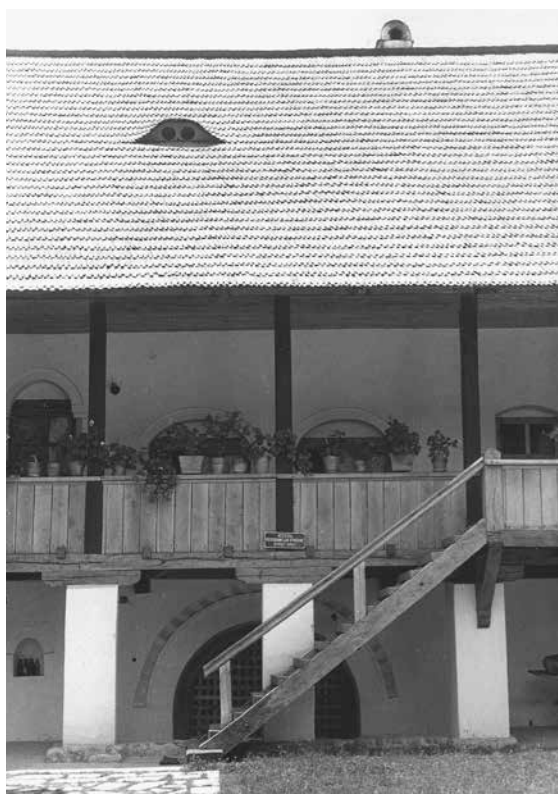
Fig. 50 Mănăstirea Polovragi, fațada Vest incintă după restaurare, 1978 (arh. Ștefan Mănciulescu)
