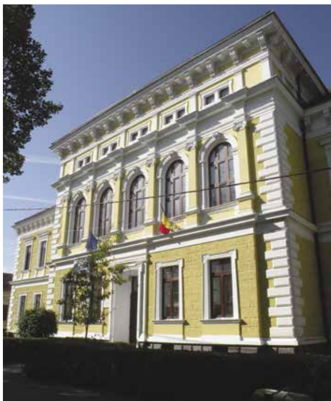
Fig. 5 Rezalitul de pe fațada principală a școlii (foto Aurelian Stroe, 11 octombrie 2017)
