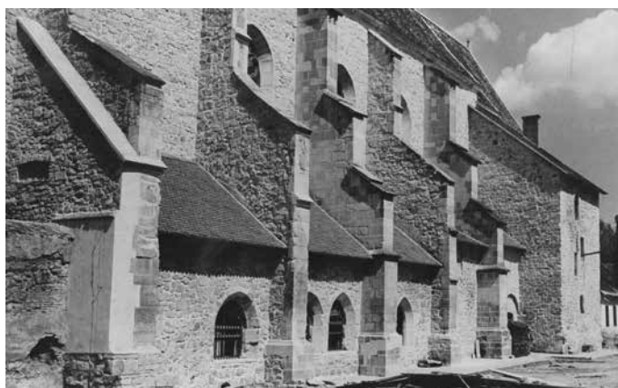
Fig. 18 Biserica reformată Matia, Cluj-Napoca, fațada Sud după restaurare, cca 1960 – această fotografie face parte din cele câteva documente conservate pe planșeta d-nei Mănciulescu la DMI
