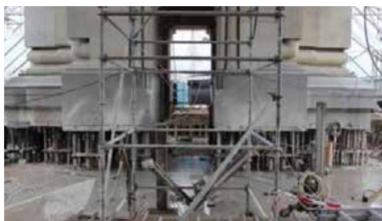
Fig. 19, 20 Sus: decuplare suprastructură de fundații, introducerea barelor de armătură pentru turnarea cadrului purtător superior | Jos: Arcul de Triumf decuplat de fundații (Credo Design, 2017)
