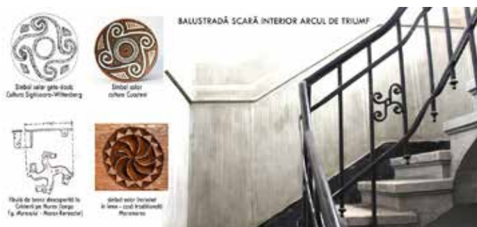
Fig. 16 Elemente ornamentale balustradă fier forjat și corespondente în semiotica din spațiul carpatic. În imagine se poate observa și paramentul interior din similipiatră – înainte de acoperirea sa cu tencuială (Credo Design, 2017)
