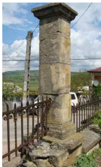
Fig. 22 Gardul istoric ce străjuiește proprietatea în partea de nord a proprietății (Șerban Sturdza)
