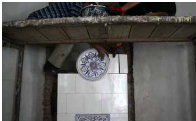
Fig. 19 Atelierul de construcție sobe, Țibănești 2015 (Alexandra Mihailciuc)
