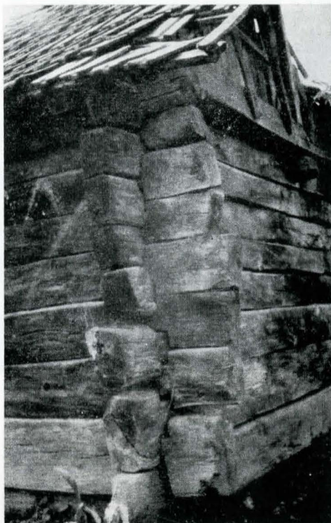
Vidimirești. Îmbinări pereți de la pivnița Totir Const.
