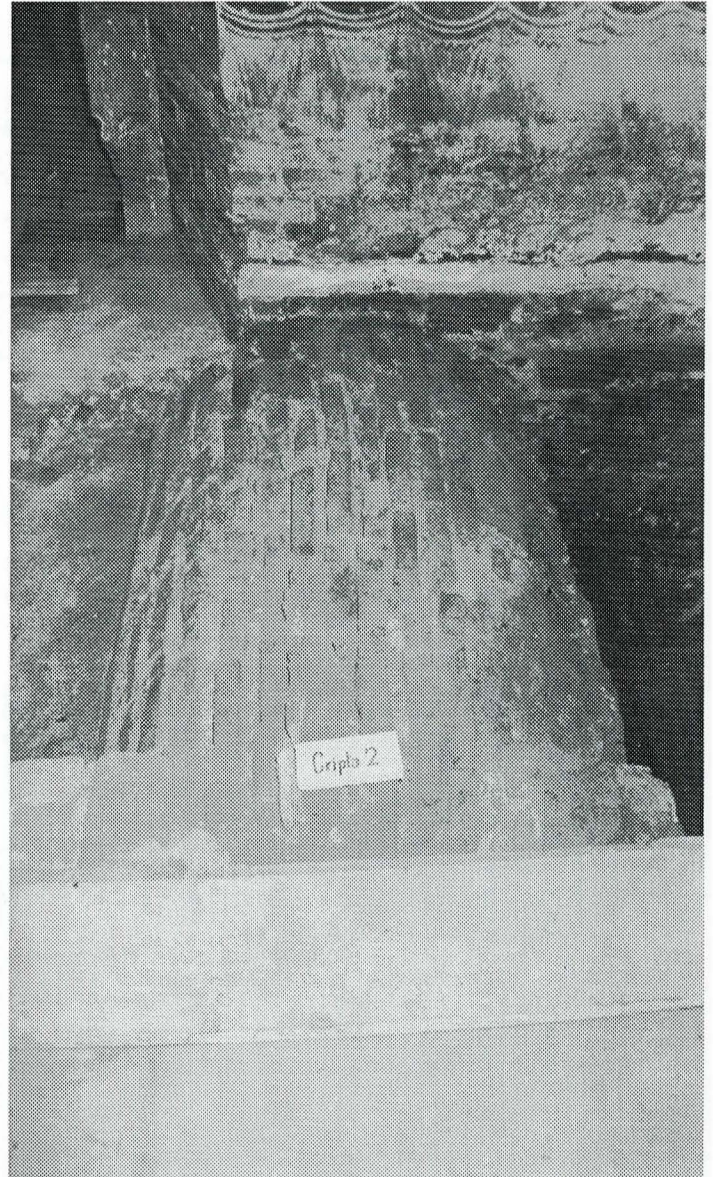
Boltirea Criptei nr. 2, cu suportji din cărămidă are susțineau, probabil, fostul soclu.
