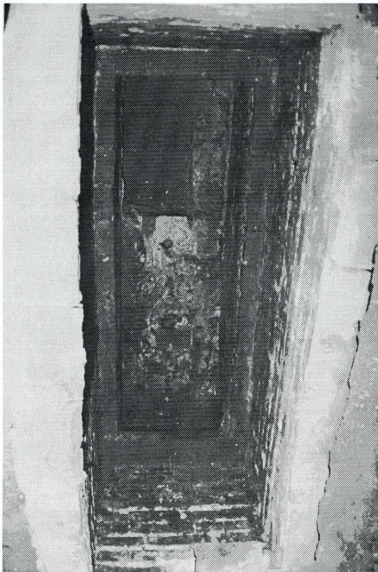
Vedere asupra Criptei nr. 11 (atribuită de noi mormântului fostului episcop de Rădăuți, Mitrofan).
