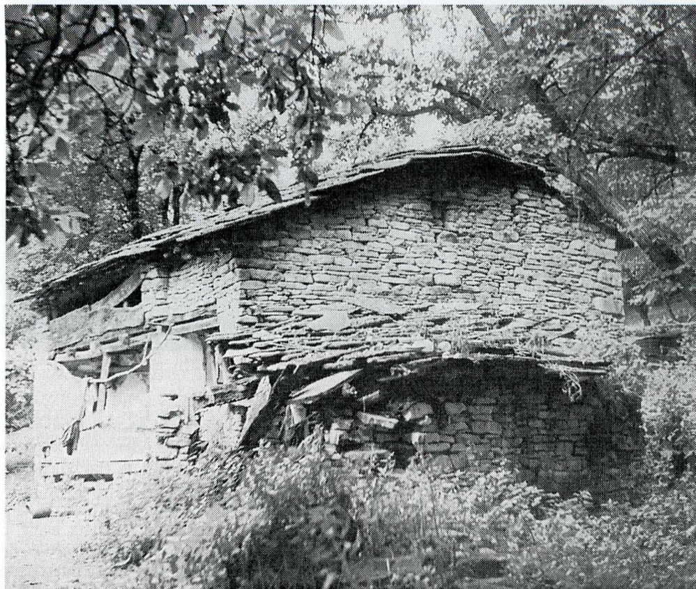
Fig. 9. Locuință din piatră, sfârșitul secolului XIX, sat Valea Mare, com. Ceru-Băcăinți, jud. Alba; învelitoarea este din lespezi de piatră
