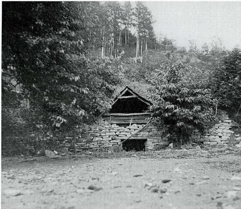
Fig. 25. Pivniță săpată în mal, sat Curpeni, com. Ceru-Băcăinți, jud. Alba
