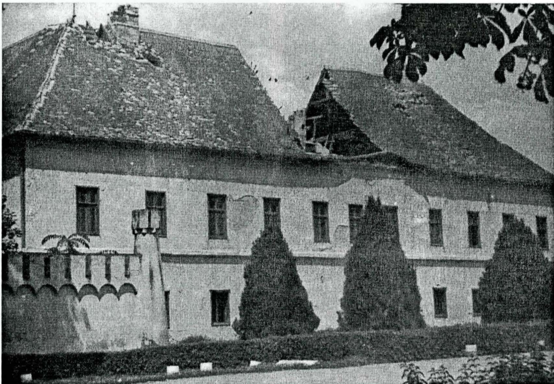
Fig. 2. Conacul de la Banloc (1793), după cutremurele din 1991.
