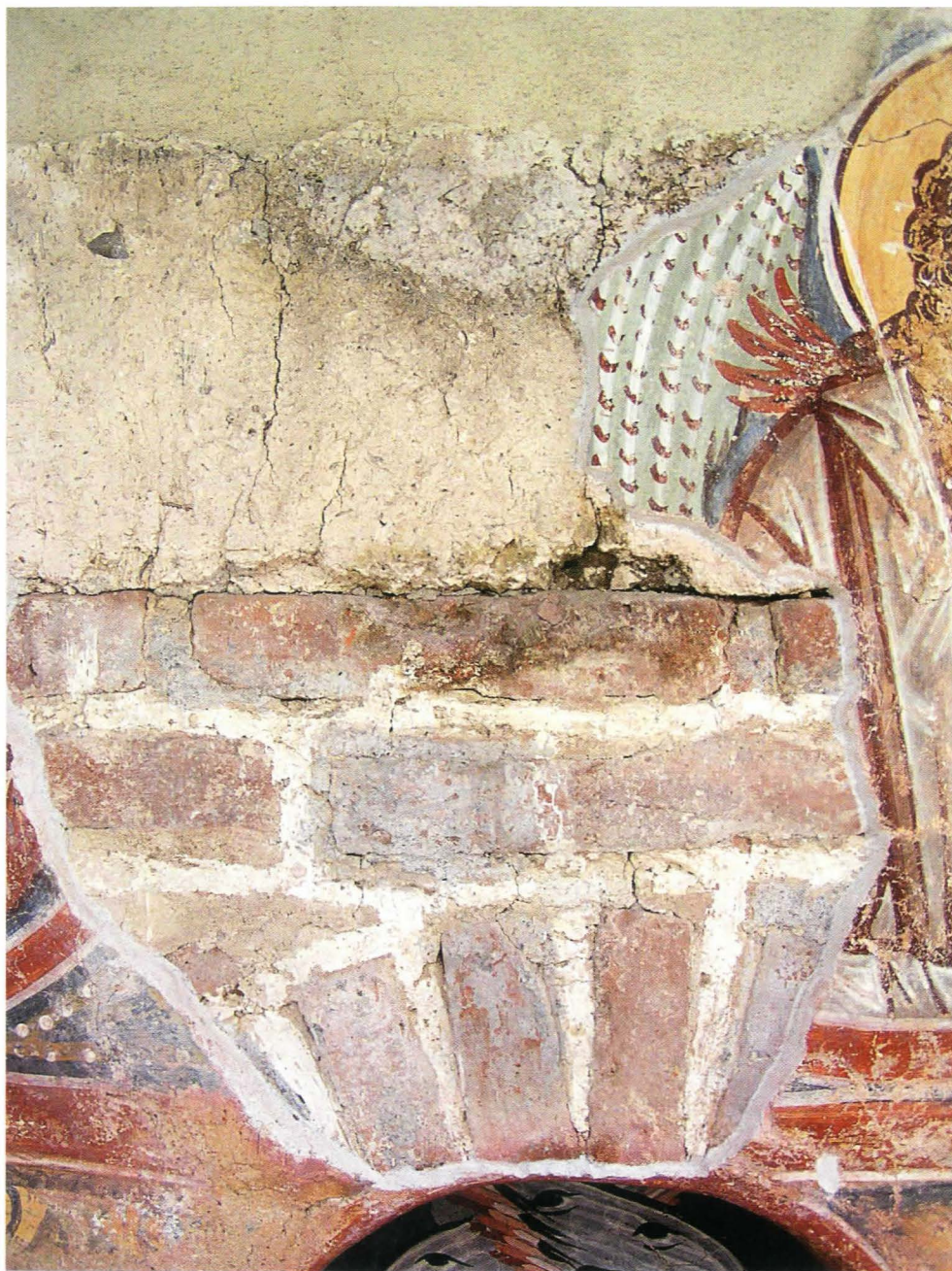
Fig. 12 – Exterior, turla. Decorație murală descoperită de sub mortare de reparație într-o lacună a picturii murale.
