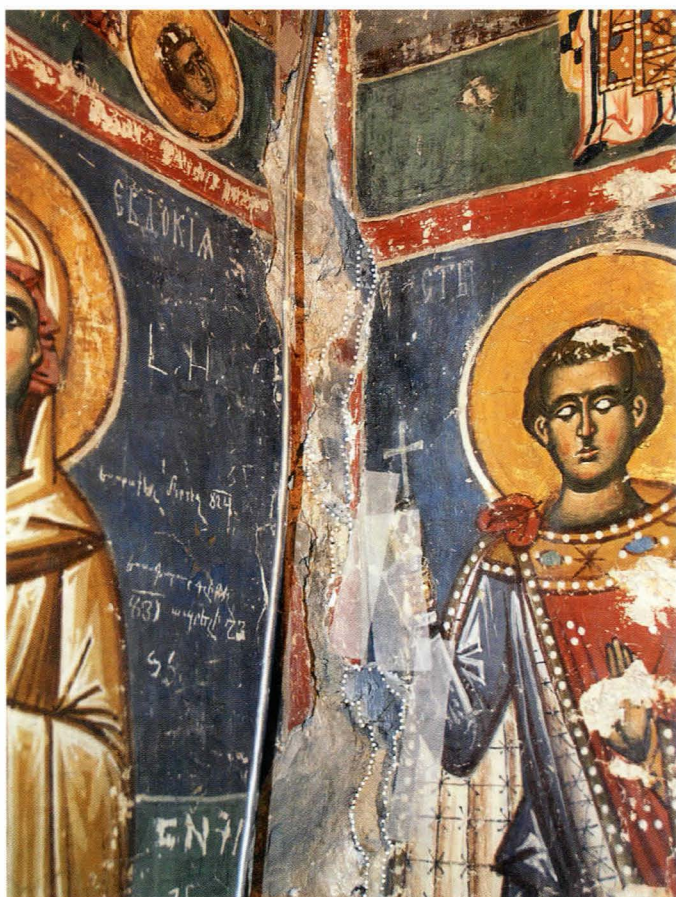
Fig. 5, 6 – Pridvor, zona de îmbinare dintre pereții de sud și est. Detalii cu pictura murală descoperită după îndepărtarea mortarelor de reparație.
