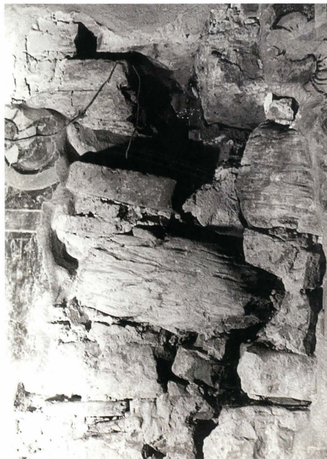
Fig. 1 – Zona de îmbinare dintre pridvor și corpul bisericii. Materiale de umplură descoperite după îndepărtarea mortarelor de reparație.
