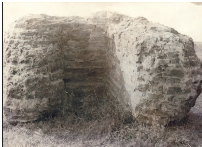
Fig. 11 - Fragmentul de zid din elevația bisericii fotografiat în 1982 (Un fragment rămas mai mic este vizibil și astăzi, tras cu tractoarele în albia pârâului Bălanu.)/ Part of the footing of the church wall, 1982
