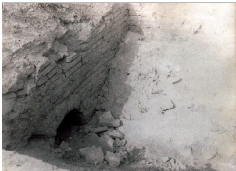
Fig. 10 - Zid despărțitor dintre încăperile laterale/ Partition wall of the side rooms
