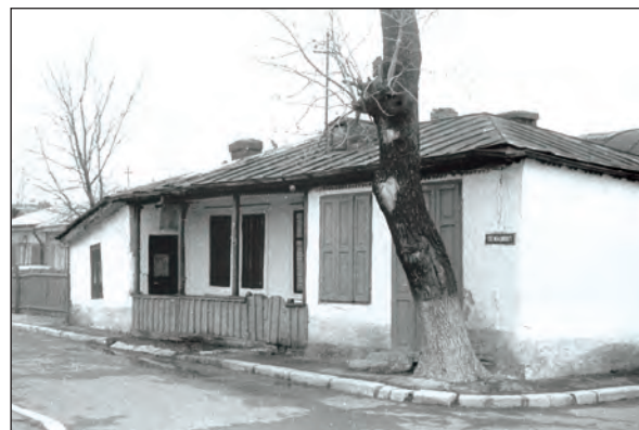
Fig. 7. Casă veche de colț, str. Merișorului
