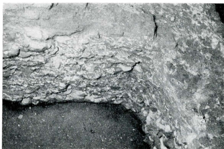
Fig. 9. Fundația absidei sudice și fundația pridvorului lărgit
