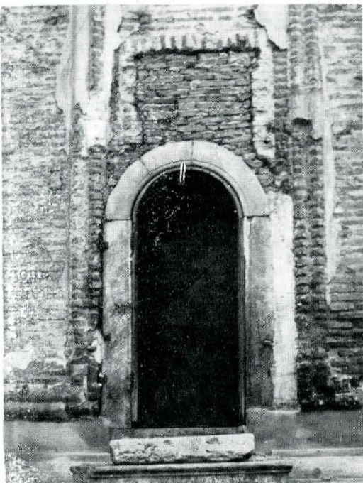
Fig. 46. Ușa din sec. XIX a diaconiconului, deasupra căreia se vede fereastra originală obturată în zidărie.
