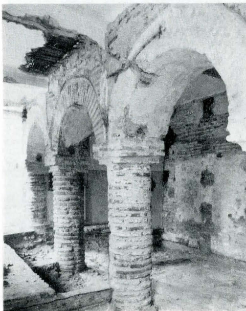
Fig. 34. Arcade în plin cîntu la parterul galeriilor arcate; lăcașul de încadrare, pe zidul de incintă, a bolții cilindrice dărîmate.
