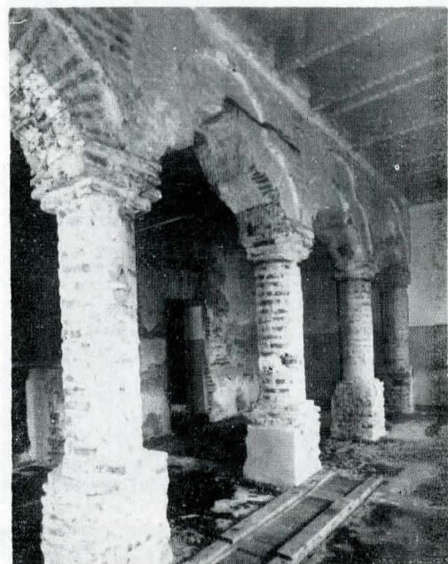
Fig. 35. Arcade treplate de la etajul galeriilor arcate.
