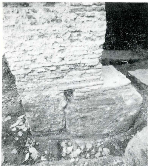
Fig. 6. Fundația și fragment din pilierul original de zid al parterului foișorului Casei Domnești (dreapta) cărora li se adaugă, fundația și zidăria de elevație de sec. XIX, suprapuse peste cea originală (stînga).
