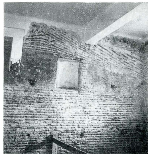
Fig. 38. Urma nașterii trompelor conice de colț ale bolților cuhniei de nord-vest.
