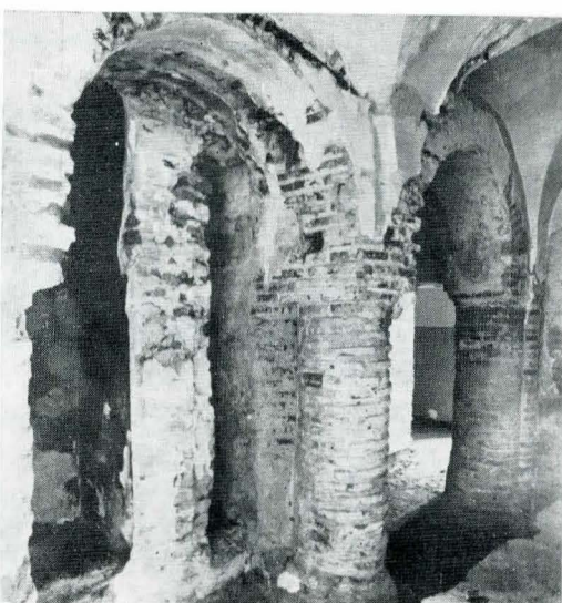
Fig. 28. Porticul de la parterul stăreției, vedere din interior.
