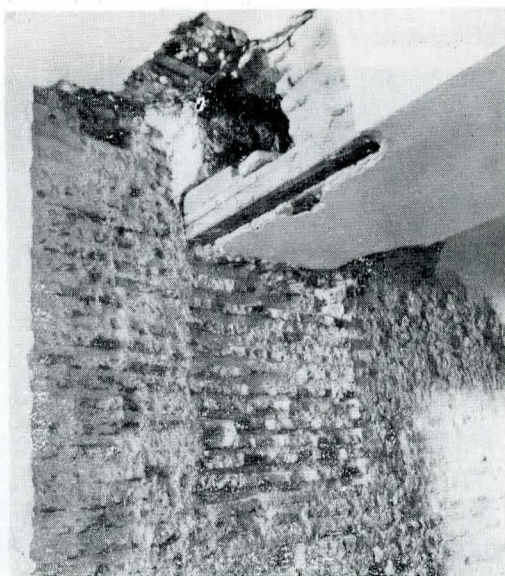
Fig. 10. Urma arcadei de NE de la parterul loggiei Casei Domnești (peretele N).
