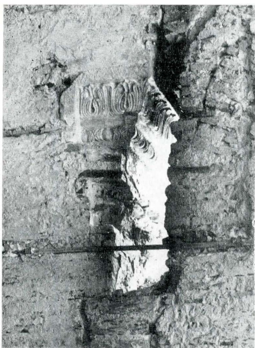
Fig. 12. Consola din vest de la etajul loggiei Casei Domnești, ascunsă în zidăria de sec. XIX.
