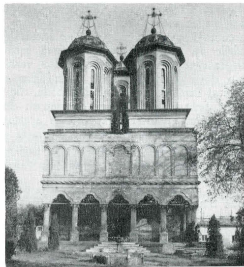
Fig. 44. Biserica, vedere a fațadei de vest.
