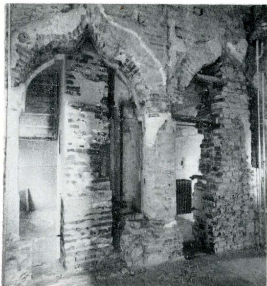
Fig. 30. Vedere din interior a porticului din nordul stăreției inclus în construcții ulterioare.
