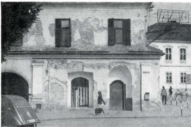
Fig. 7. Sondaje pe fațada sud-vest.
