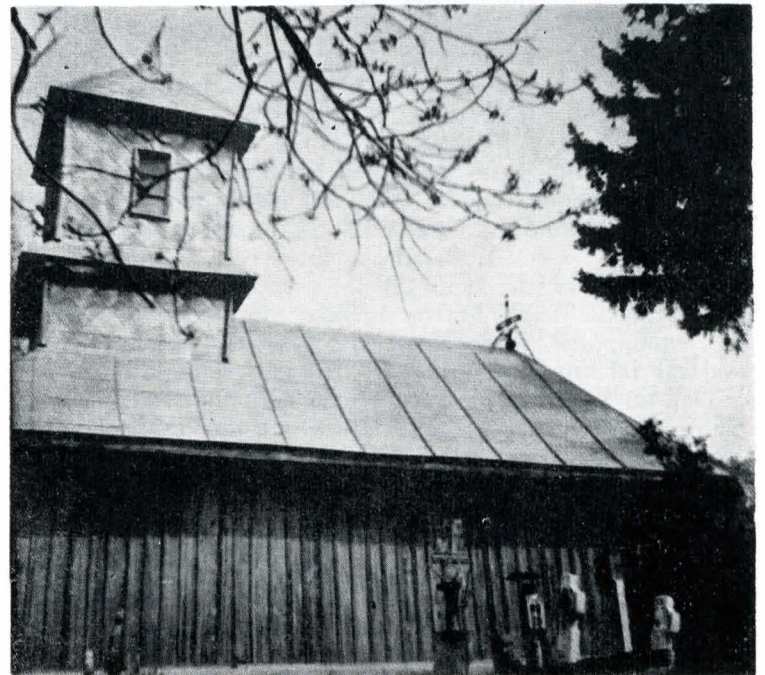
Fig. 3. — Biserica din Valea Boului, peretele exterior acoperit cu șipci.
