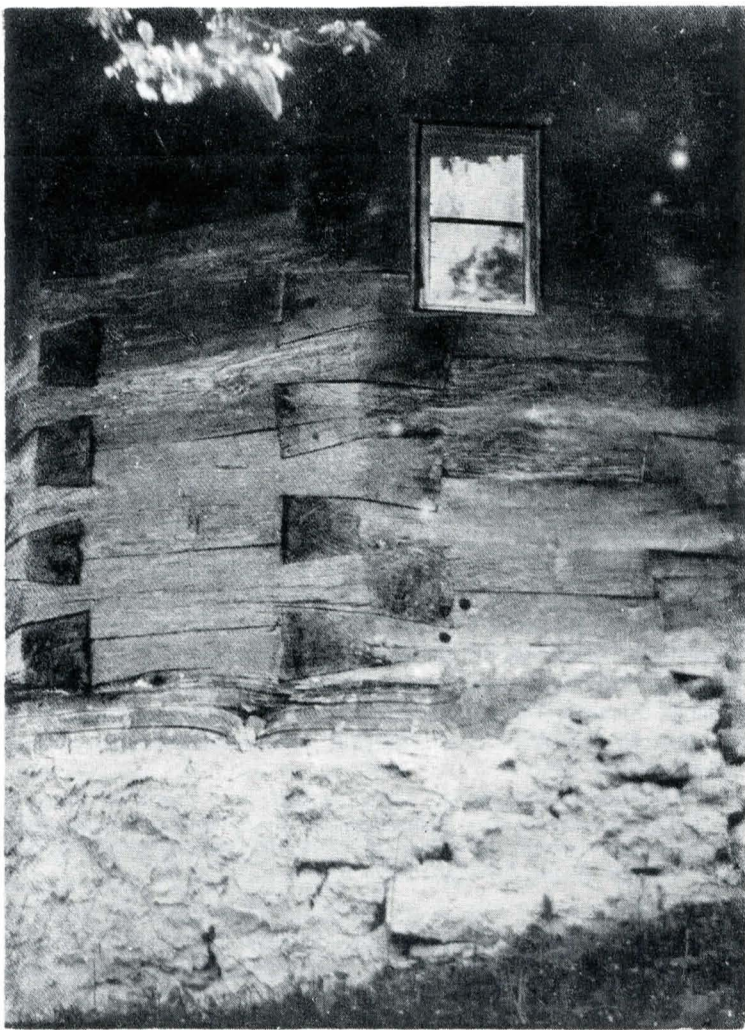
Fig. 2 — Detaliu de îmbinare a birnelor la absida bisericii din Bozioru de Sus
