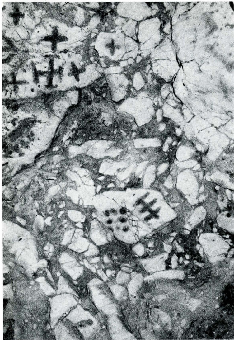
FIG. 5. DETALIU DE PE PERETELE DE NORD-EST PE CARE SE AFLĂ PĂTRATUL CU PUNCTE ȘI ALTE SEMNE.
