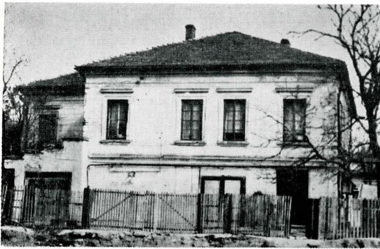
Fig. 5 Casa din Strada 1 Mai nr. 4. Fațada spre Str. 1 Mai.
