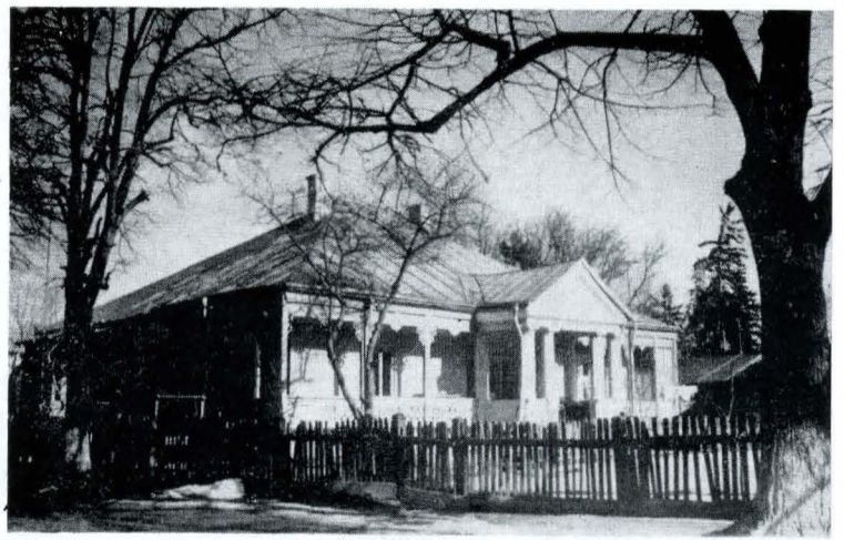
Fig. 9 — Casa din str. Bucovina nr. 11. Arhitectură populară cu pridvor clasicist din zidărie.
