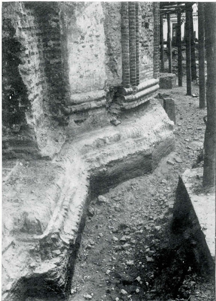
Fig. 3 Biserica Crețulescu din București, restaurată de C.M.I. între 1934—1936, arh. Ștefan Balș. Dezvelirea soclului pe latura de nord, între absida laterală și altar, prin coborîrea la nivelul de căleare. Foto W. Weiss, 1934, clișeu C.M.I., fototeca D.M.I.
