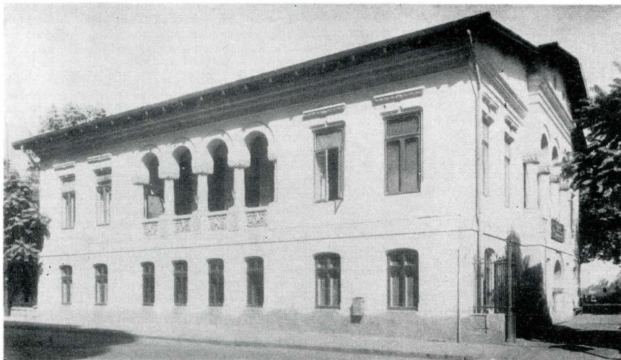
Casa Disescu, azi sediul Institutului de Istoria artei (arhitect: Gr. Cerchez)
