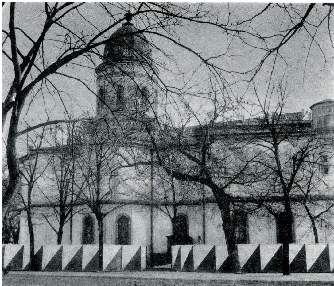
Fig. 12. Fațada nord (situația din 1976)
