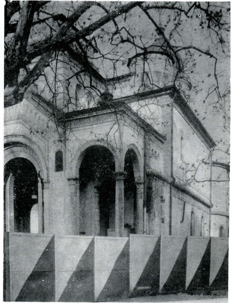
Fig. 11. Colțul de sud-vest (situația din 1976)
