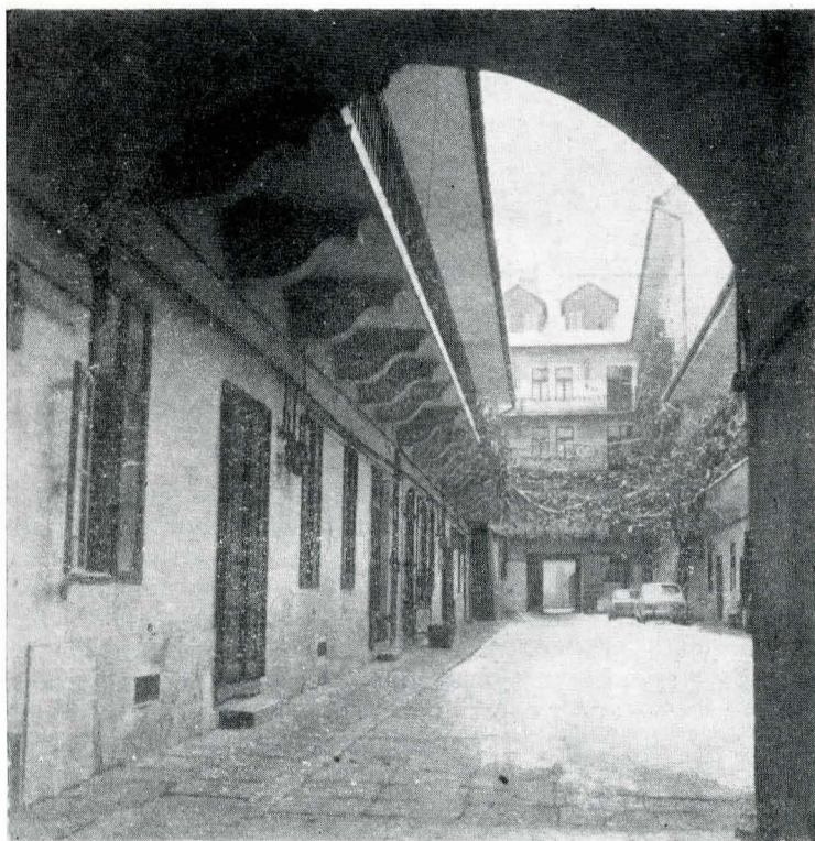
Fig. 8. Str. P. Groza nr. 6 — situația actuală.
