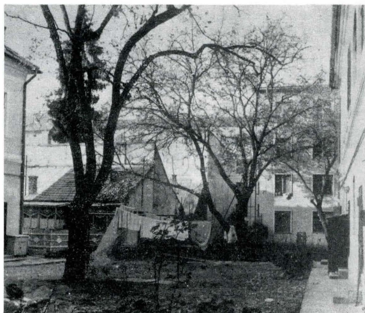
Fig. 6. Palatul Teleki – situația actuală.
