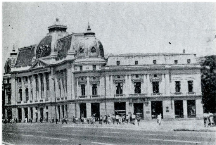
București. Clădirea Bibliotecii centrale universitare. Vedere generală după efectuarea lucrărilor de restaurare
