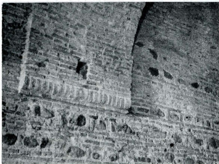
Fig. 5. Zidăria pivniței și arc-dublou.
