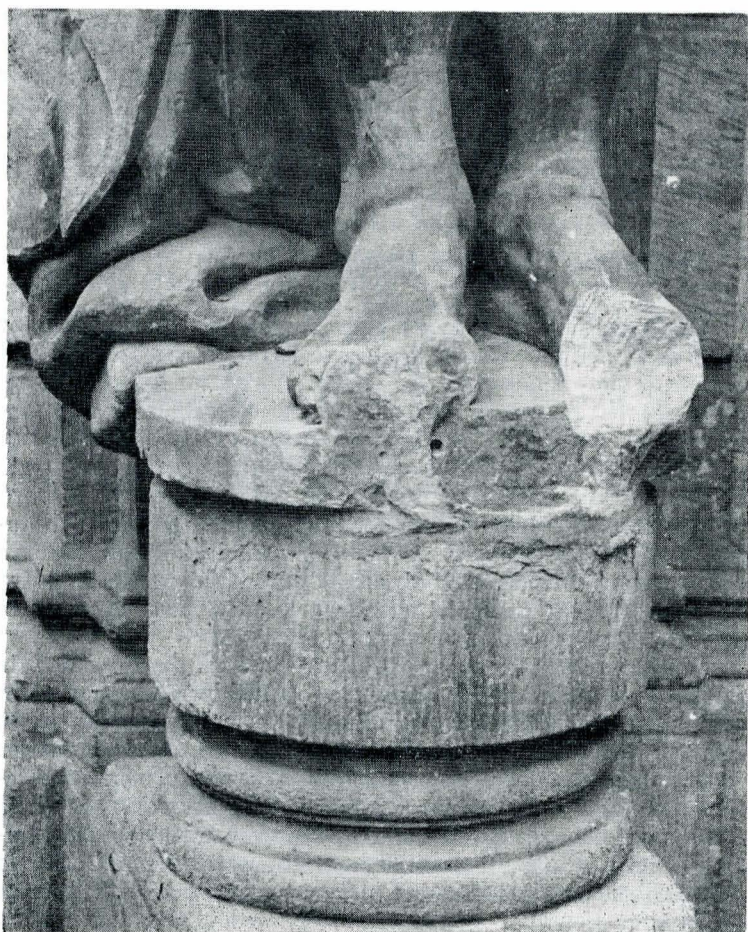
Fig. 4. Detaliu de la un atlant (fig. 3). Pregătire pentru restaurare cu „Mineros”
