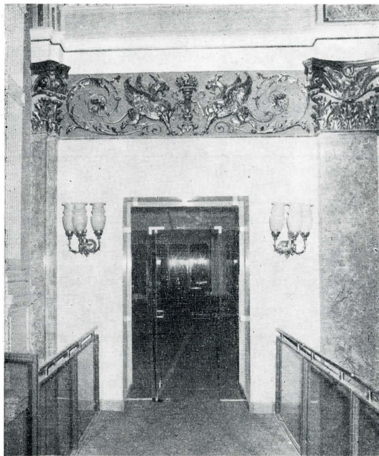
20. Decorație cu grifoni, după restaurare. În prim plan se observă pasarela nouă, modernă, din securit ca și ușa către magazinul tratat și el, prin contrast, într-o arhitectură nouă.
