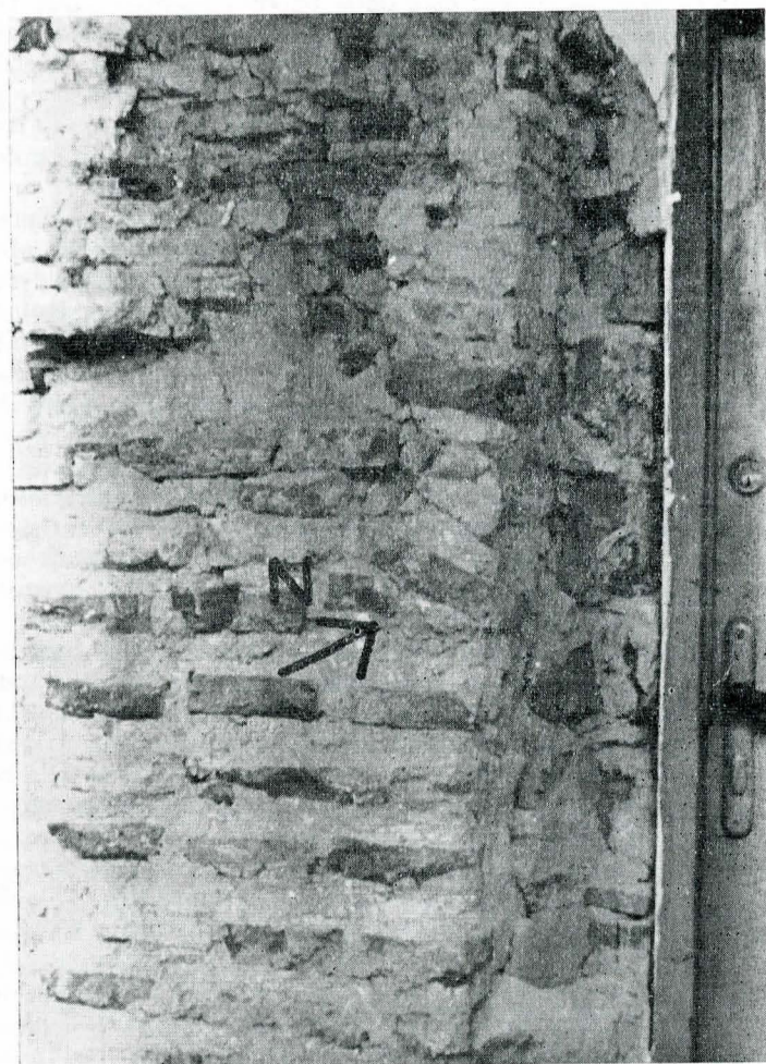
29. Nașterea arcului unei uși exterioare, pe fațada est
