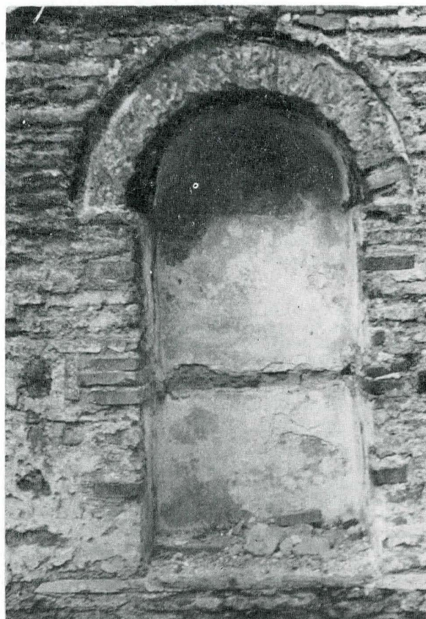
27. Casa din veacul al XVII-lea (firidă). Se văd: raftul de lemn de la partea inferioară și lăcașurile celorlalte două rafturi. Firidele au fost prevăzute cîte una la fiecare cameră, pentru a servi ca dulapuri înzidite
