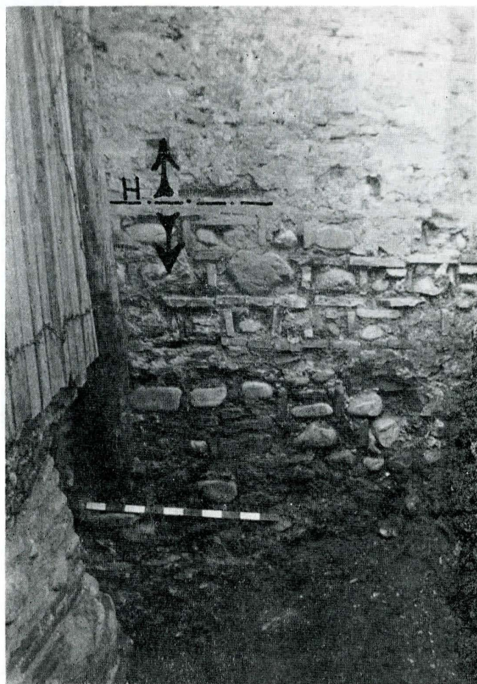
14. Vedere exterioră a peretelui de la capătul de nord al casei boltite din veacul al XV-lea (de la linia notată H în sus, zidul a fost refăcut în etapa 1640–1645)
