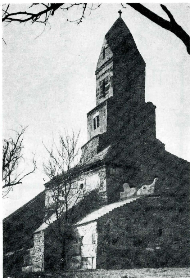
Vechea biserică din Densuș, Hunedoara (sec. XII-XIII): reutilizarea unor piese și materiale de construcție din ruine antice
