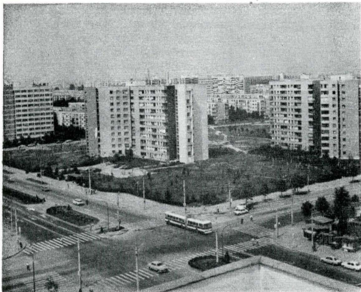
Construcții noi pe bulevardele Leontin Sălăjan și Liviu Rebreanu din București.
