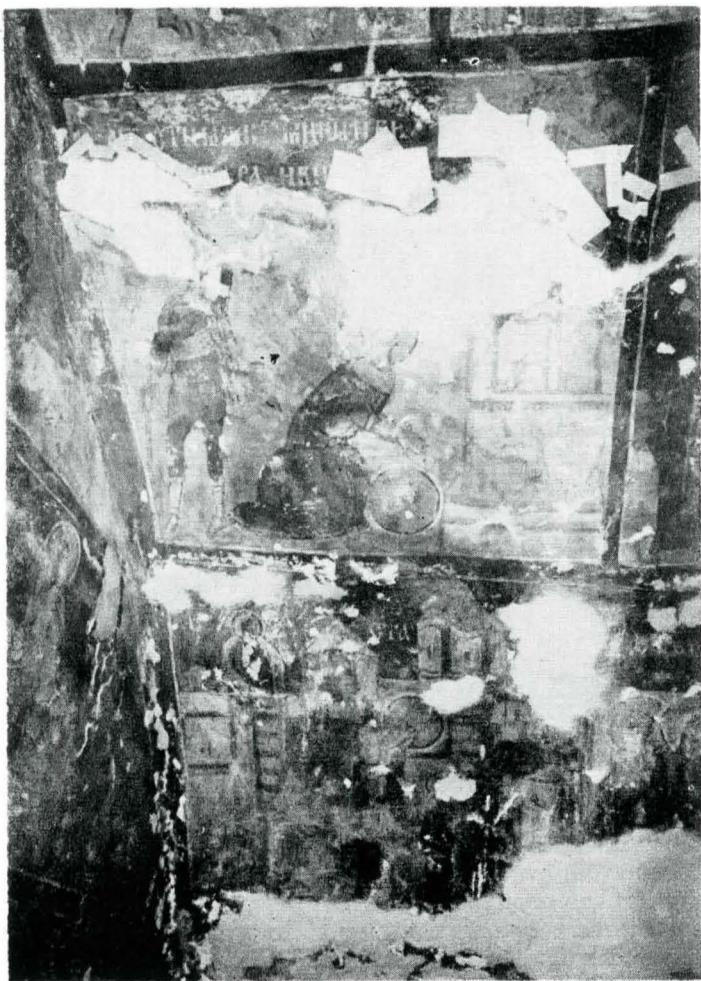
Bolta nord, registrele 2—3; chituiră lacunelor cu mortar de frescă.
