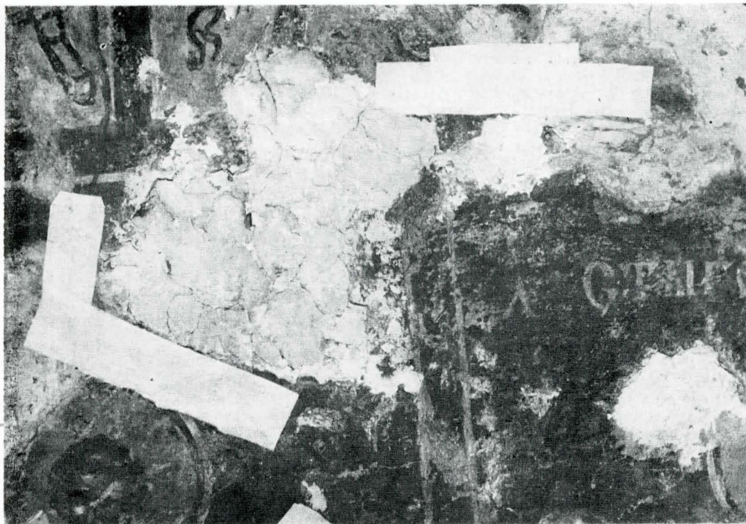
Bolta sud, detaliu din registrul 3; deca- pări, asigurare cu hîrtie Pelur.
