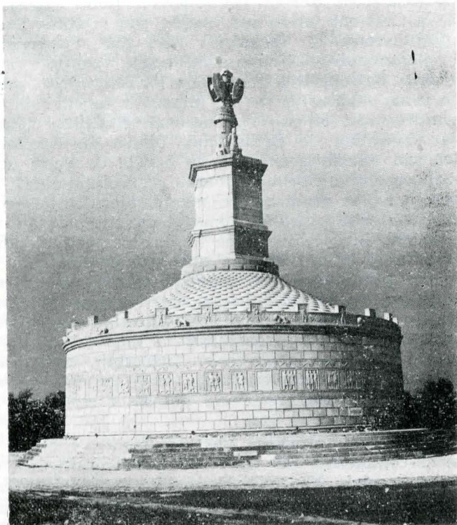
Fig. 21. Monumentul Tropaeum Traiani , vedere după restaurarea ştiinţifică efectuată în ultimii ani.
