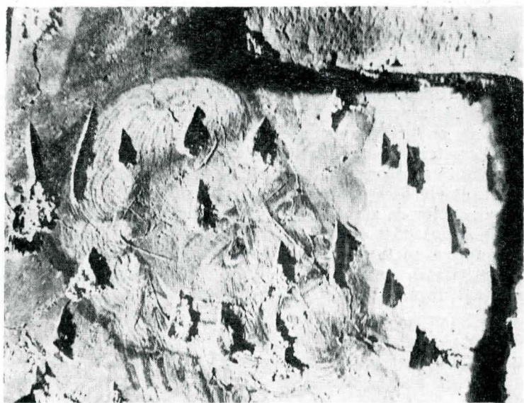
7—8. Naos — absidă sud. Detalii din pictura veche; lumina razantă evidențiază degradările picturii vechi
