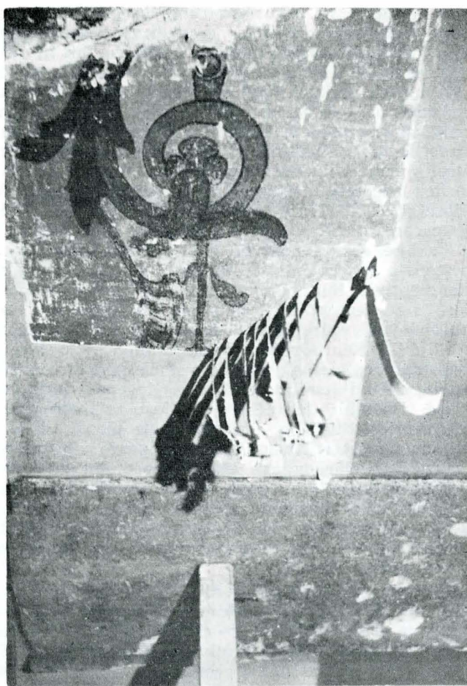
Camera 33. Hol mare, imagine cu lumină razantă în timpul operațiilor de îndepărtare mecanică a suprapunerilor de vopsitorii după înmuieri locale cu comprese chimice.
