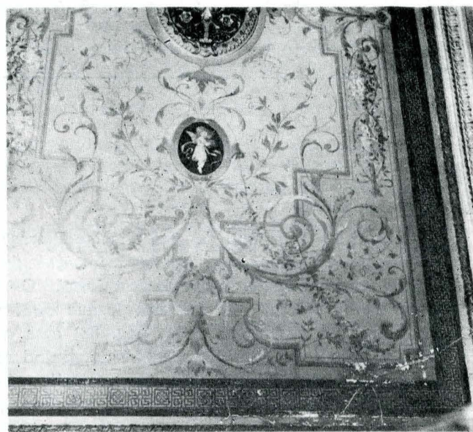
Plafon hol, casa din str. Justiției nr. 40
