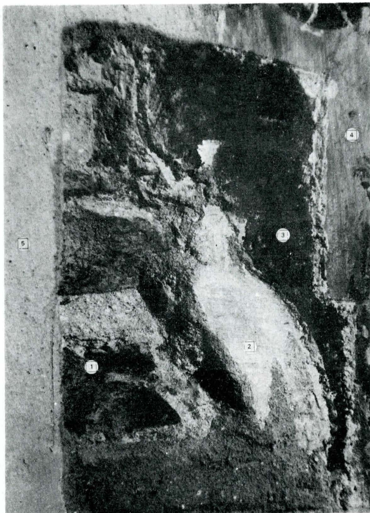
Sondaie stratigrafice (p. 89—90). 1. Zidăria. 2. Stratul de „nivelare”. 3. Primul strat de frescă. 4. Al doilea strat de frescă. 5. Tencuieli de reparație și văruieli.
