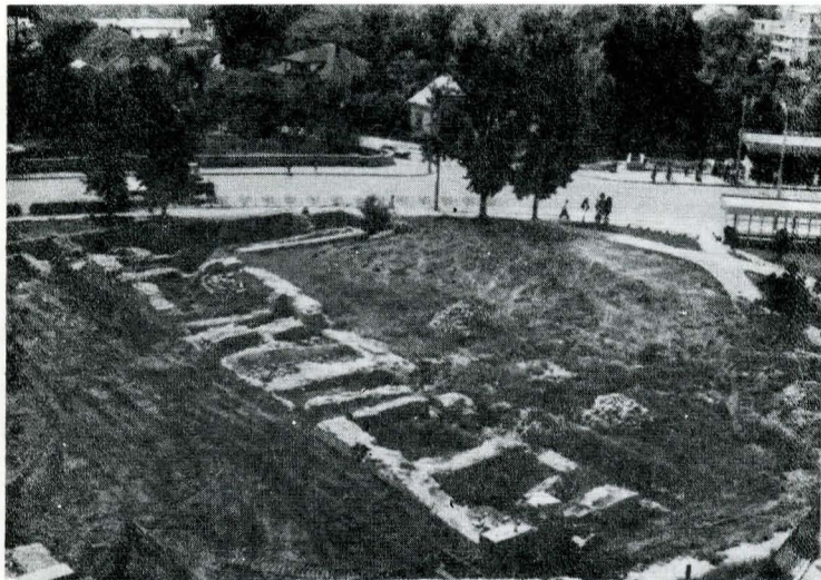
Ruinele Curții Domnești din Suceava, înainte de restaurare (1988)
