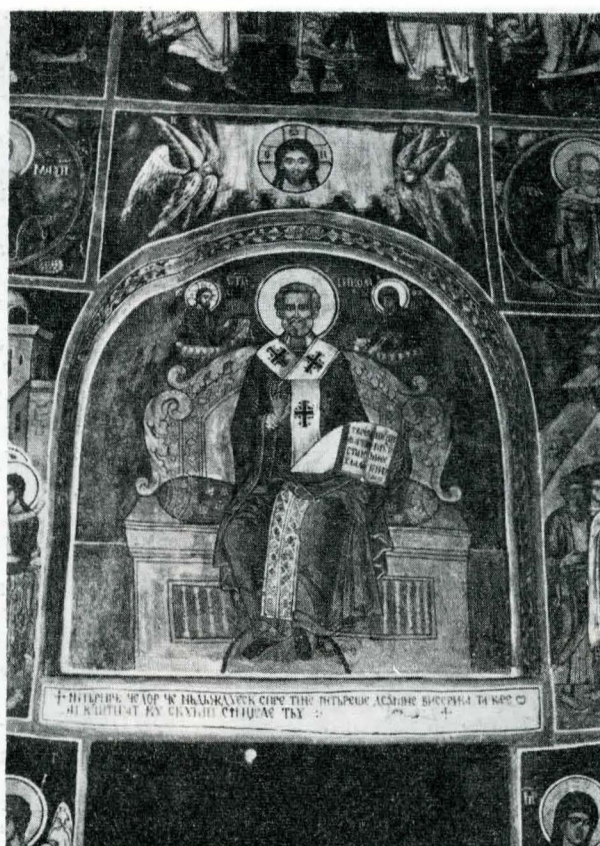
Pronaos, perete est, reg. III, IV, V, foto înainte de montarea schelei. Se observă zonele fisurilor și dislocărilor de zidărie care au fost mascate de chituri necorespunzătoare.
