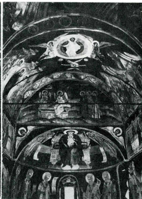
Altar, foto înainte de montarea schelei de lucru; se observă pe axul bolților chitrice maschează fisuri profunde, strat masiv de depuneri de praf și fum, săruri, lacune etc.
