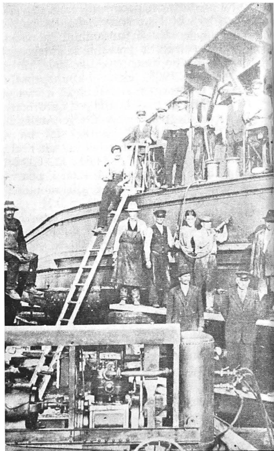
Repararea unei nave în Atelierele Serviciului Porturilor Maritime în 1931
