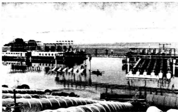
Stația de pompare a apelor în Sistemul de navigație Mostiștea
