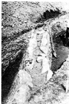
Rigolă din lespezi de piatră care proteja apeductul din 1584
