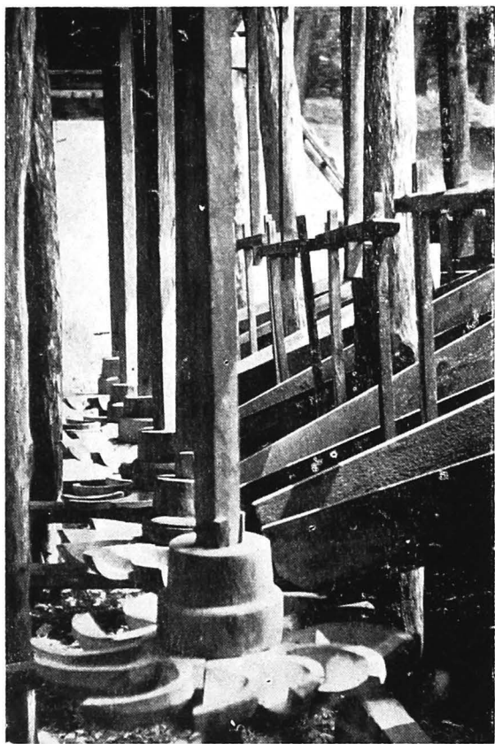
Moară cu șase ciuturi, Găleșoia, jud. Gorj. Detaliu — roțile orizontale (ciuturile) și sistemul de aducțiune
