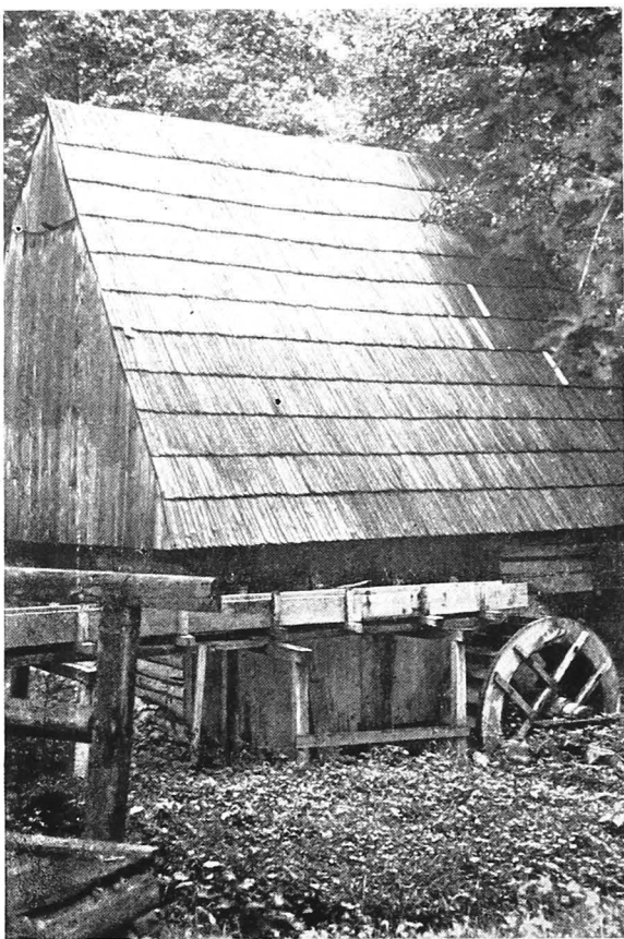
Pivă de haine și ulei, Tălmăcel, jud. Sibiu. Vedere de ansamblu — în prim plan roata motrice cu aducțiune superioară
