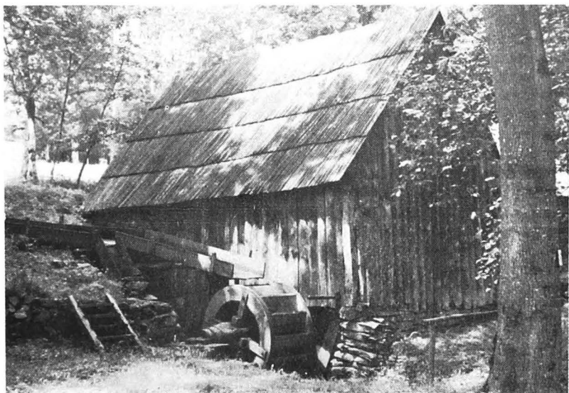
Piuă de haine, Rod, jud. Sibiu. Vedere de ansamblu, sistemul de aducțiune a apei și roata motrice cu aducțiune superioară
