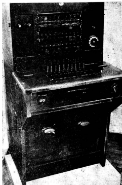
Centrală telefonică manuală pentru 30 de numere, cu baterie locală, construită în 1942 la Intrupin, dera „Vestitorul” (actuala „Electromagnetica”)
