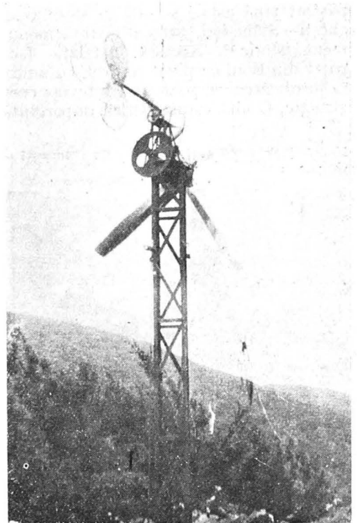
Microcentrală electrică eoliană Helegiu-Bacău
