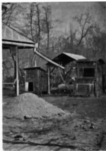
Fig. 3. În Viile Satu Mare, după umplerea fântinii, apa prin demontarea burlanului, este dirijată în altă parte.
