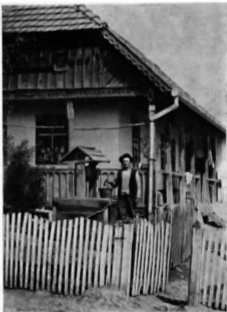
Fig. 2. Fântina cu captarea apei de ploaie din satul Medişa.
