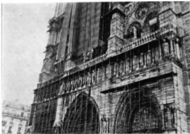
Catedrala Notre Dame — Lucrări de curățire a fațadei de vest.
