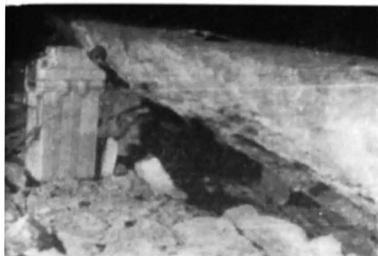
Faliera vetrei orizontului IV de la mina „Victoria”, după exploatare (foto L. Drăgănescu)
