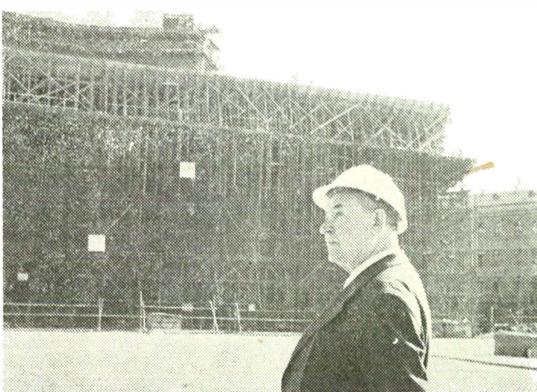
Pe șantierul noului Teatru Național, 1969
