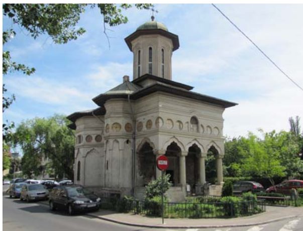
Fig. 1 – L’ancienne église Saint Eleuthère, située jadis dans un îlot de la Dâmbovița.
