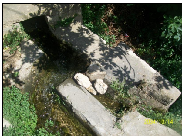
Fig. 8 – Un système ancestral de partage des eaux dans les anciens vergers de Kesra (Cliché de l'auteur, 2014).
