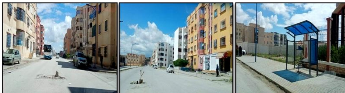
Figs. 28, 29, 30 – État général des voiries dans les quartiers (Dahdouh, 2020).
