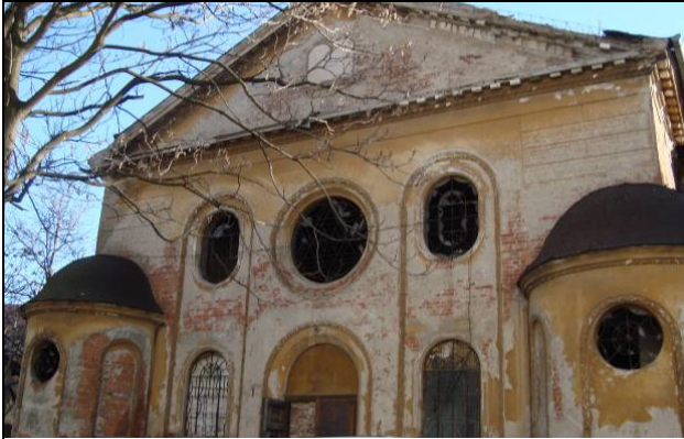
Fig. 3. Absidele de colț ale sinagogii de pe strada Primăriei din Oradea
